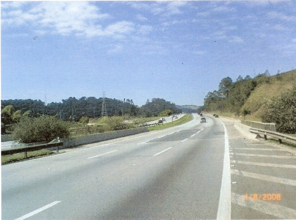
OBRA 04 SP 280 km 43+500 m – Vista da pista de rolamento.
