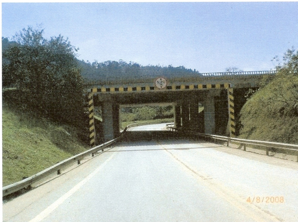
OBRA 04 SP 280 km 43+500 m – Vista lateral da obra.
