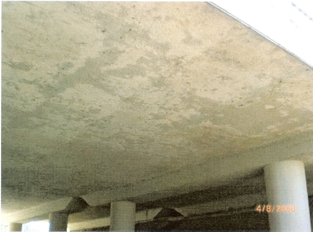
OBRA 04 SP 280 km 43+500 m – Vista inferior da obra.
